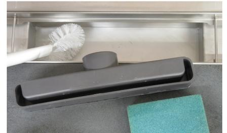
**3** Grobe Verschmutzungen im Rinnenkörper mit fließendem warmen Wasser und haushaltsüblichen Reinigern entfernen. Hilfreich ist hier ein Schwamm oder eine Bürste. Selbige Vorgehensweise ist bei dem Siphon anzuwenden. Vor dem Wiedereinbau den Einsteckstutzen des Siphon einfetten (z.B. mit Armaturen fett oder Vaseline).
