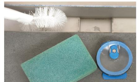
**3** Grobe Verschmutzungen im Rinnenkörper mit fließendem warmen Wasser und haushaltsüblichen Reinigern entfernen. Hilfreich ist hier ein Schwamm oder eine Bürste. Selbige Vorgehensweise ist bei dem Ablaufverschluss anzuwenden. Vor dem Wiedereinbau den Dichtring des Ablaufverschlusses einfetten (z.B. mit Armaturen fett oder Vaseline).
