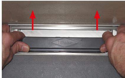
**2** Den Siphon an beiden Seiten greifen und aus dem Ablaufstutzen heraus drücken, das ist je nach Einbausituation zur Wand oder von der Wand weg.
