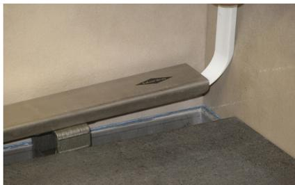
**1** Mit dem zum Lieferumfang gehörenden Rostheber (weißer Kunststoffhebel) wird die Rostabdeckung an- bzw. herausgehoben.
