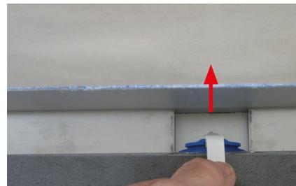
**2** Den Rostheber oben in die Nut des Ablaufverschlusses stecken und diesen heraus drücken, das ist je nach Einbausituation zur Wand oder von der Wand weg.
